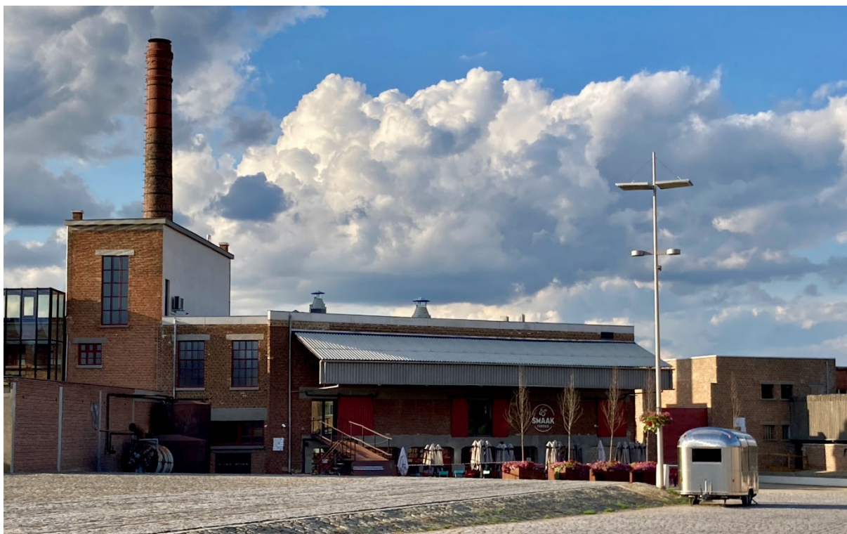
Afbeelding 85 Bistro Smaakfabriek ter hoogte van de luifel, gevestigd in het gerestaureerde deel van de stoomstroofabriek in Borgloon (K. De Clercq, Fotoreportage in Borgloon, Wellen, Alken, Sint-Lambrechts-Herk en Hasselt 2021)
